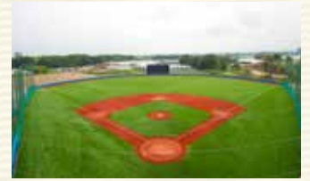
2017年竣工の硬式野球場
