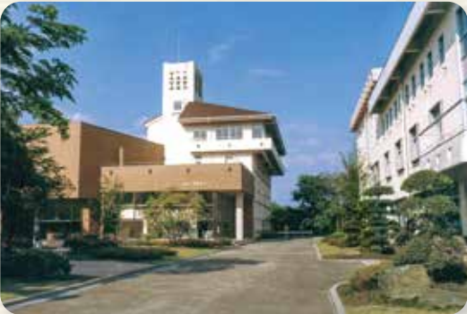
須賀友正記念ホール・2号館増築（1985年）
