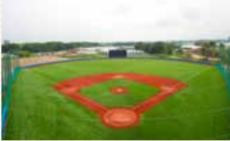
2017年竣工の硬式野球場
